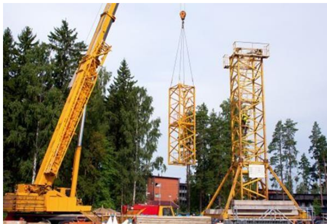
Слика 30. - Монтажа крана
