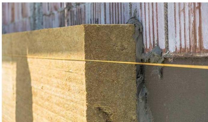
Слика 89. - Постављање камене вуне на фасаду
