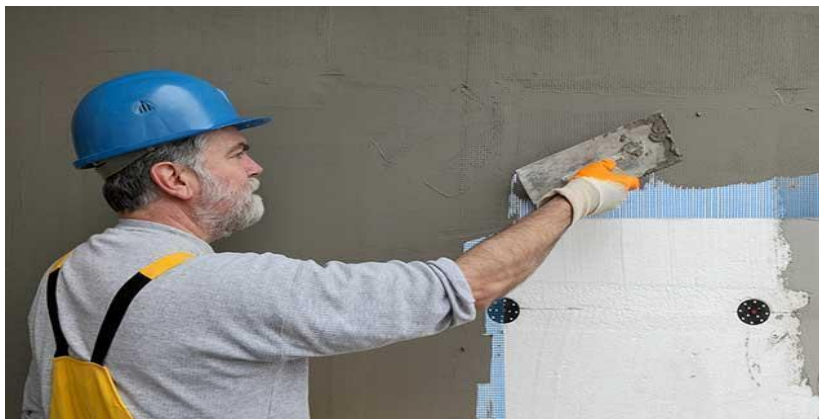
Слика 92. - Наношење лепка
