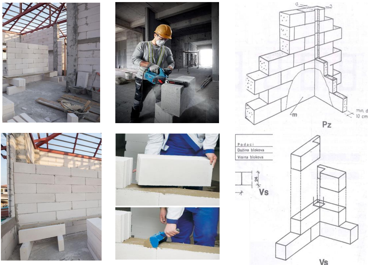
Слика 64. - Зидање блоковима од ћелијастог бетона
