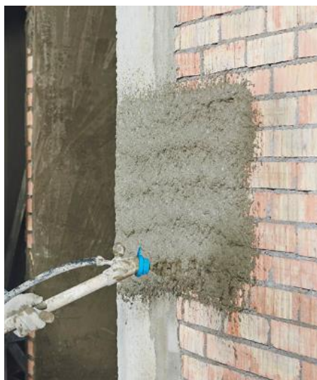
Слика 87. - Машинско малтерисање зидова
