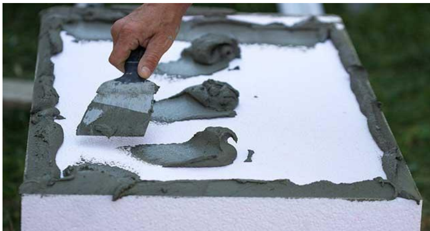
Слика 91. - Наношење лепка на термоизолациону плочу
