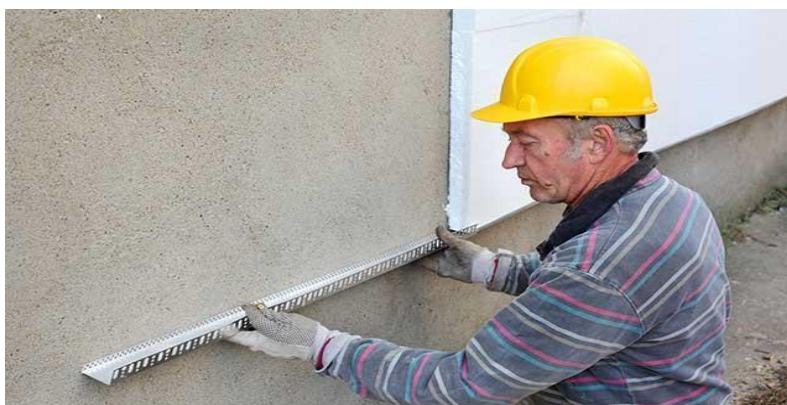
Слика 90. - Постављање почетног профила (лајсне)
