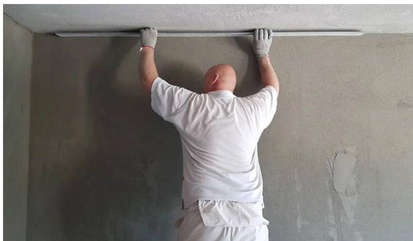
Слика 85. - Летва за скидање малтера и проверу равнине зидова и плафона
