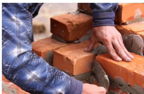
Слика 20. - Уградња опеке при зидању
