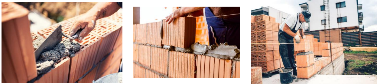
Слика 54. - Зидање гитер блоковима
