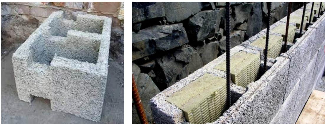
Слика 17. - Шупљи дурисол блокови се користе као калупи, тј. као изгубљена оплата за специјалне зидове од бетона
