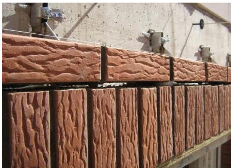
Слика 98. - Дилатација изведена испод реда конзола од нерђајућег челика
