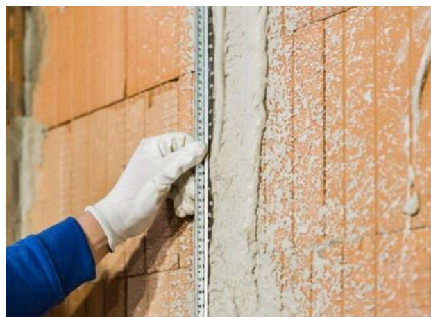
Металне вођице за малтерисање – (Дилатационе вођице за машинско малтерисање)
