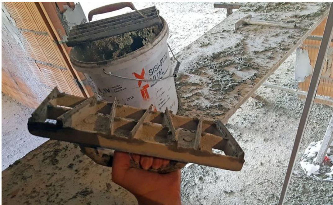
Слика 86. - Гребач за фино скидање вишка малтера
