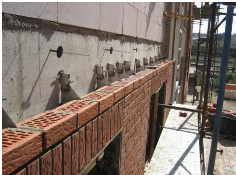
Слика 97. - Пример уградње конзола
