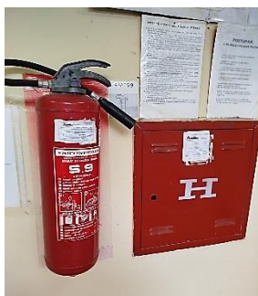
Слика 41. - ПП апарат и хидрант
