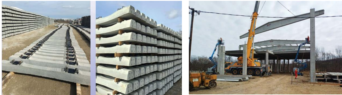
Слика 80. - Примери преднапрегнутих елемената (прагови за пругу, кровни носач)
