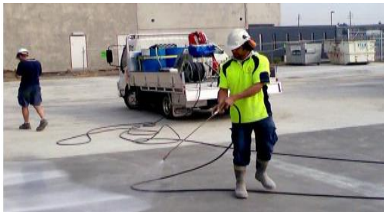
Слика 96. - Нега бетона прскањем
