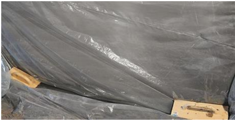
Слика 95. - Заштита бетона фолијом
