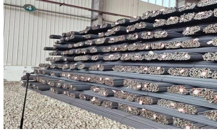
Слика 2. - Складиштење арматуре
