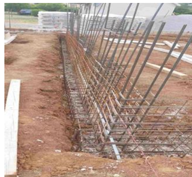
Слика 50. - Арматура темеља са испустима за стубове (контрагреде)
