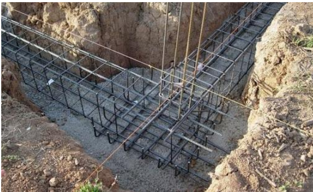
Слика 48. - Арматура темеља
