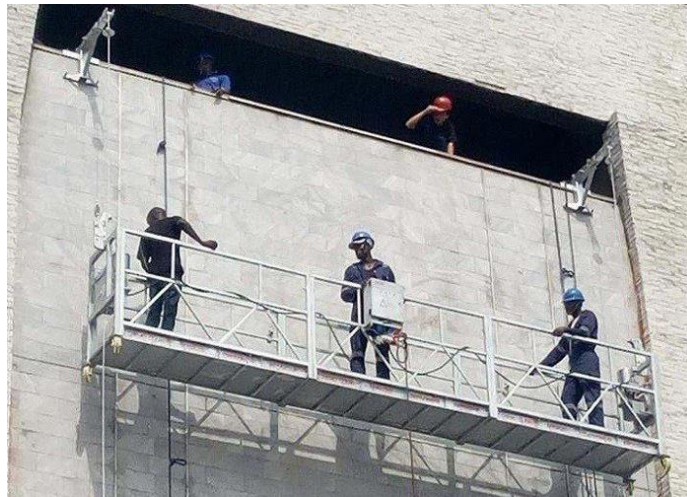
Слика 122. - Висећа радна платформа
