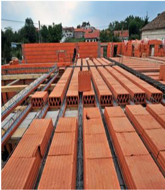
Слика 37. - Међуспратна конструкција са ферт гредицама
