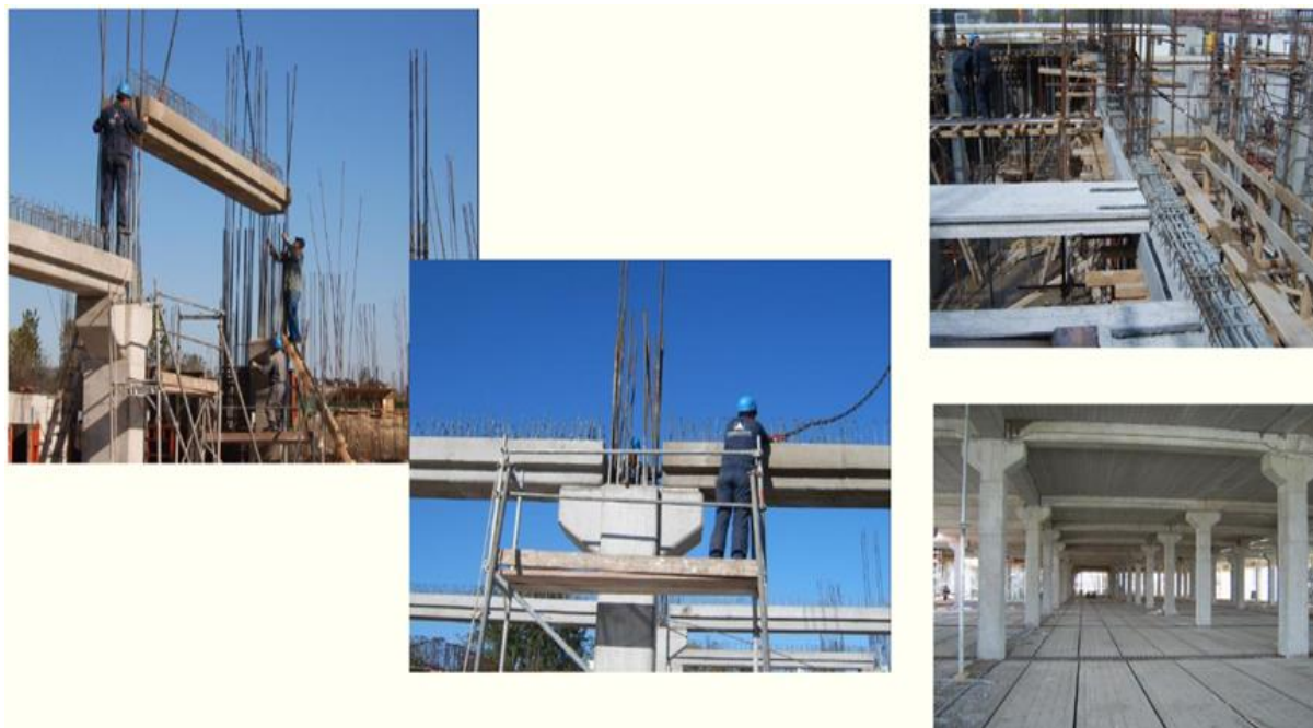
Слика 100. - Монтажа скелетног система
