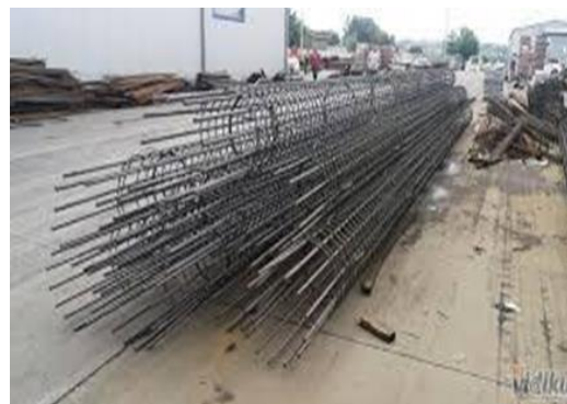
Слика 52. - Арматуре за шипове
